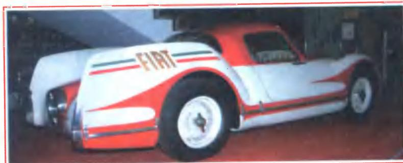
Экспериментальный «Фиат» 1954 года, двигателем которого служила газовая турбина. Во время испытаний машина показала скорость 250 километров в час.
