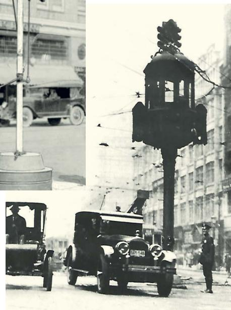
конструкцию патента, а ещё через два года, 5 августа 1914-го, сразу 4 электрических светофора были установлены в Кливленде, штат Огайо. Их создал Джеймс Хог. Его конструкция была похожей: тоже два электрических фонаря, но их переключение сопровождалось ещё и звуковым сигналом.
