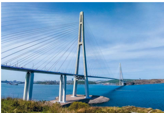
Мост из Владивостока на остров Русский стал рекордсменом среди вантовых мостов по длине.
