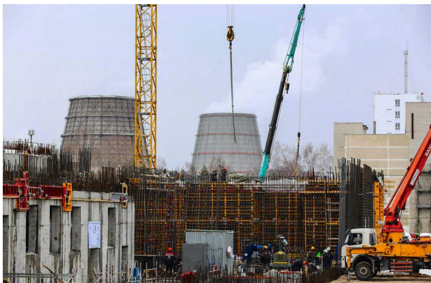
Строительство нового комплекса для реактора на быстрых нейтронах.
