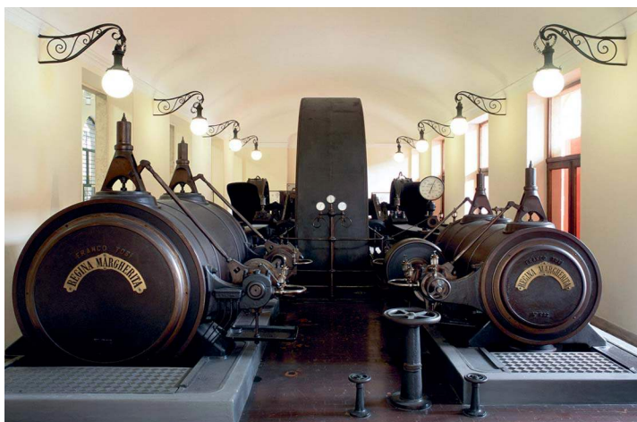
Теплоэлектростанция Regina Margherita когда-то обеспечивала электричеством крупную шёлковую фабрику.
