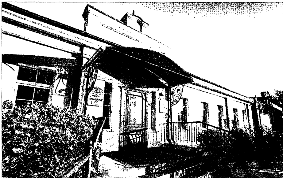
Здание, в котором находится музей «Горная аптека» (ул. Ползунова, 42)
