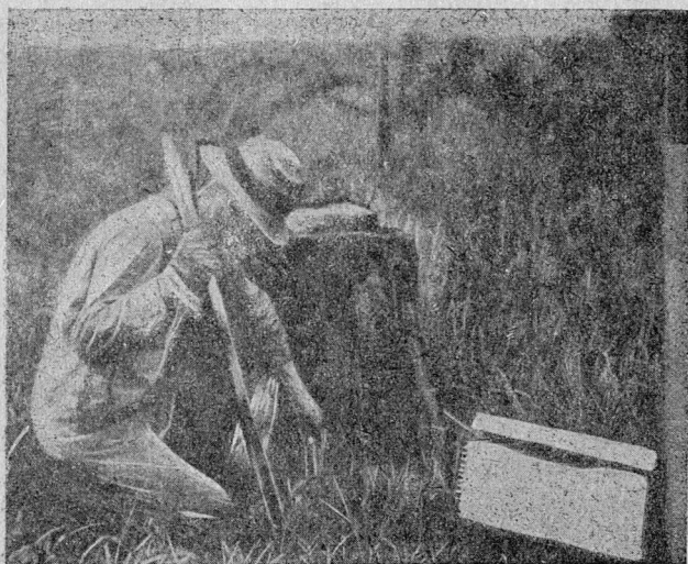
Рис. 13. Закладка патрона под пень (Америка).
