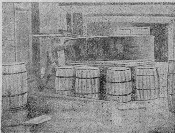
Рис. 10. З-д «Вахтан». Вращающийся чан для розлива канифоли.
