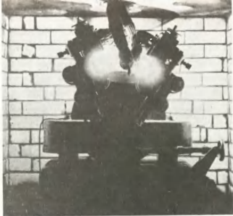
Вращающийся искровой разрядник английской передающей радиостанции, оповестившей флот о начале войны.
