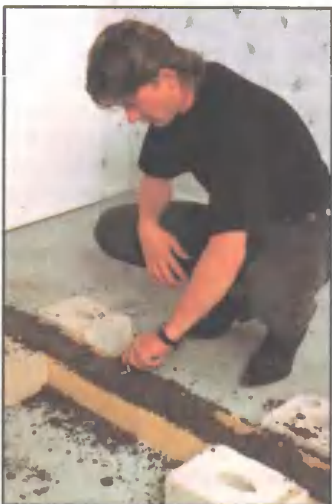
5. Арматурные прутки полностью закрывают раствором.
