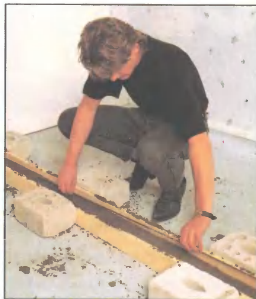
4. Закладывают два стальных прутка Ø6 мм не ближе 15 мм от края во избежание коррозии. Арматура обязательно должна заходить внутрь профиля.
