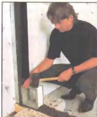
6. Особое внимание надо уделить установке первого блока. От этого будет зависеть качество всей конструкции.
