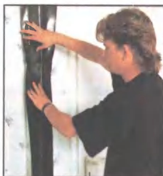
2. Пенопласт закрывают битуминированным картоном (пергамином).
