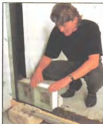
7. Кладку стеклоблоков ведут по натянутому шнуру, оставляя между ними зазор для шва в 12 мм, для чего применяют шаблон — мерную пластинку заданной толщины.
