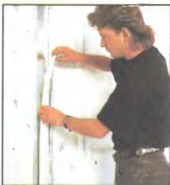
1. В профиль укладывают прокладку из пенопласта, служащую буфером при температурных перепадах.
