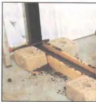
1. В профиль укладывают прокладку из пенопласта, служащую буфером при температурных перепадах.
