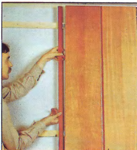
Тщательные стыки между панелями обеспечивают гребнями, которые вставляют в пазы.
