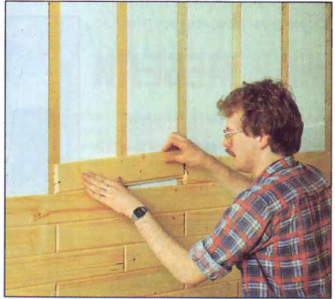
Обшивка профилированными планками требует основы определенной конструкции. Вертикальный стык между планками приходится на рейки каркаса.
