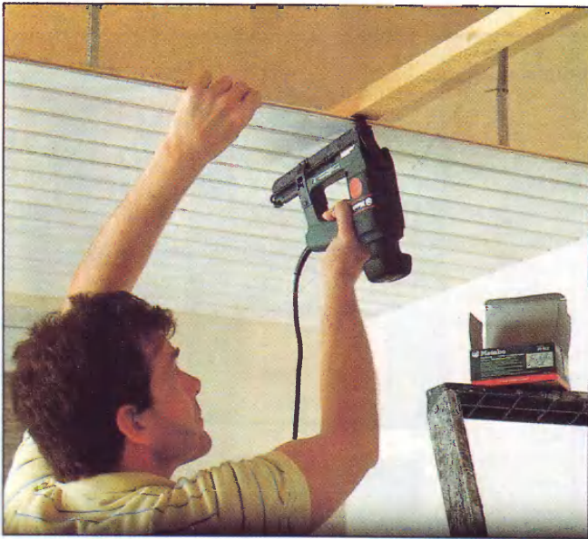
Подвесной потолок из вагонки быстро монтируется и дает возможность использовать изоляционные материалы.
