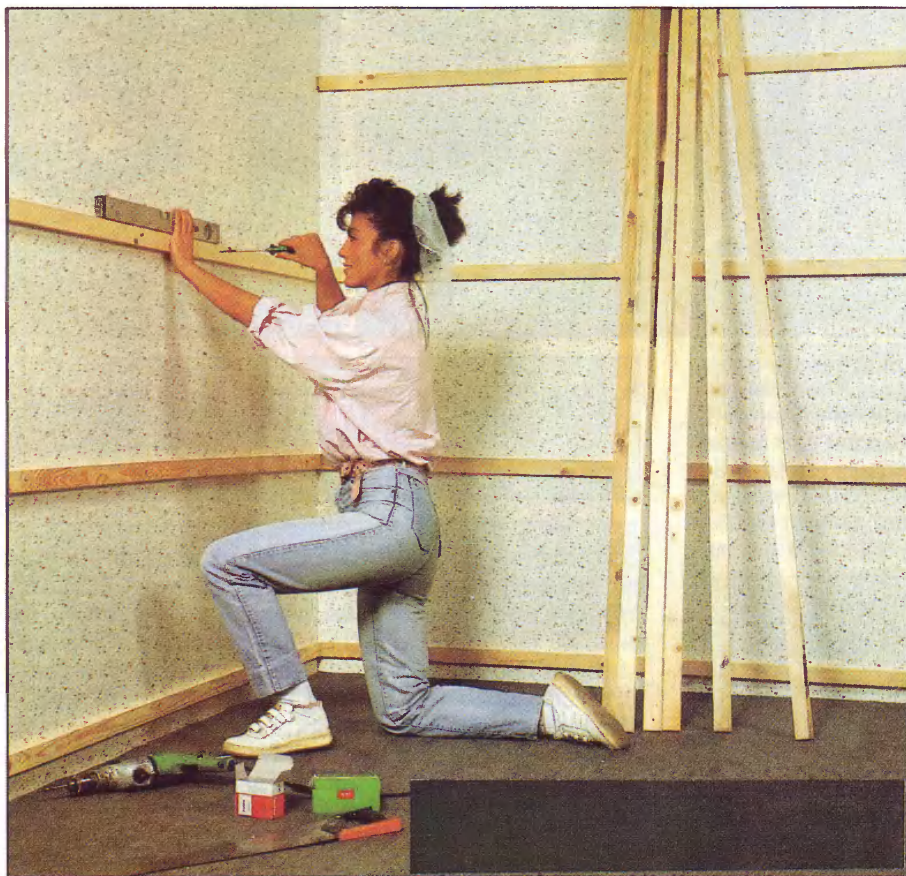
Для изготовления каркаса при обшивке внутренних стен достаточно простых планок. Их монтируют горизонтально, а обшивку делают вертикальной.
