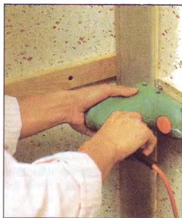
Для изготовления каркаса при обшивке внутренних стен достаточно простых планок. Их монтируют горизонтально, а обшивку делают вертикальной.
