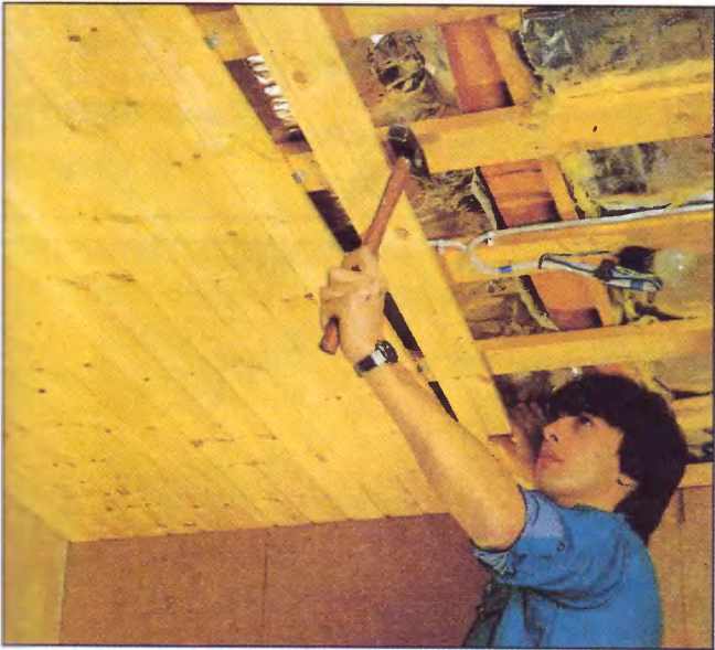
Подвесной потолок из вагонки быстро монтируется и дает возможность использовать изоляционные материалы.
