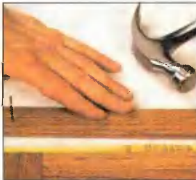
14. Стыкуя линолеум с деревянным полом, используйте деревянные планки.
