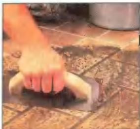
10. Для сглаживания неровностей пола используйте выравниватель поверхности.
