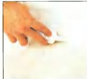
13. Заделайте стыки по периметру помещения и вокруг вертикальных выступов латексом
