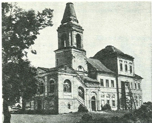
г. Севск. Петропавловская церковь. 1701 г.
