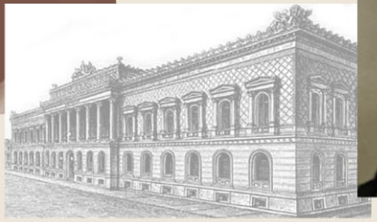
Das neue Auktionsamt in London, das im März 1924 fertiggestellt wurde.
