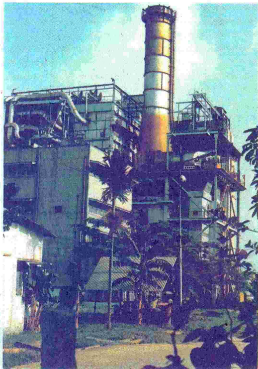
Тепловая электростанция «Читтагонг» в Бангладеш.
