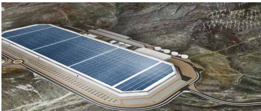
Гигафабрика компании «Тесла» в Неваде, которую заложили в 2014 году, станет ежегодно изготавливать батареи литий-ионных аккумуляторов общей емкостью в 35 гигаватт-часов электроэнергии. Отсюда и название
