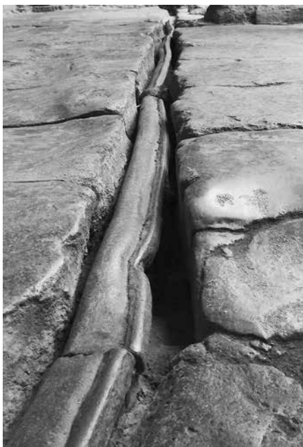
Такой свинцовый водопровод археологи нашли в термах британского Бата
