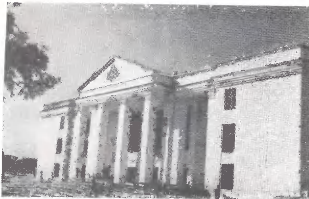
62. Строительство клуба стекольного завода в поселке «Огни»
