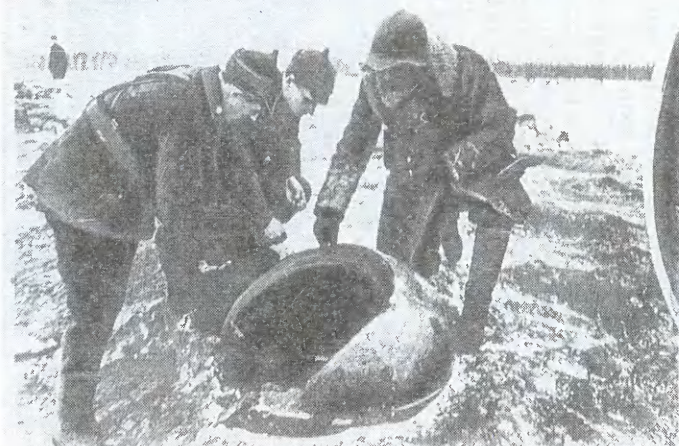
Номандеры осматривают разбитый артиллерией бронекорпус смотровой вышки ДОТ
