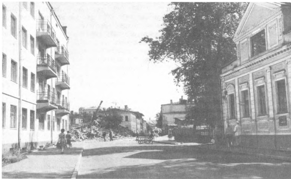
Снос домов в Кречетниковском переулке для строительства Нового Арбата. Москва. 1962 г.
