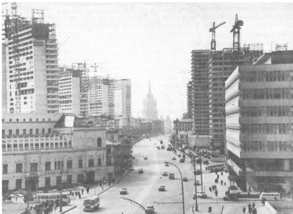
Вид строящихся зданий на проспекте Калинина. Москва. 1967 г.
