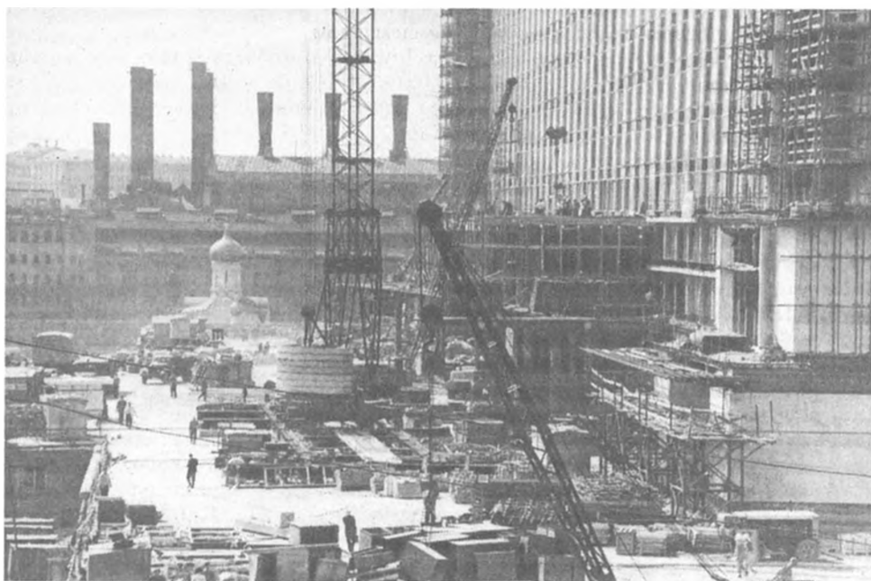
Вид на строительство западной части гостиницы «Россия». Москва. 1968 г.
