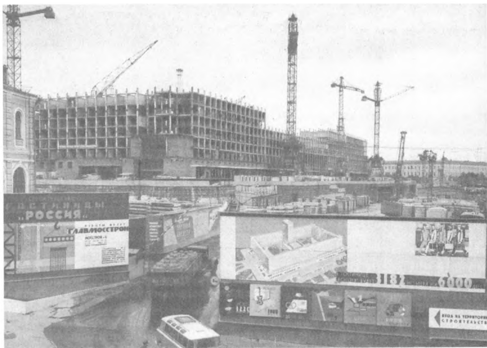
Вид на строительство гостиницы «Россия». Москва. 1964 г.
