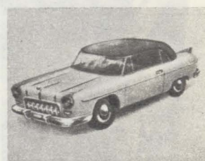
Кузов этого автомобиля выполнен методом формовки в электростатическом поле высокого напряжения, 1955 г. Фары и облицовка из алюминированной резины.
