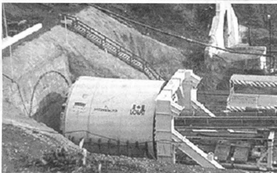
Проходческий щит на старте.
