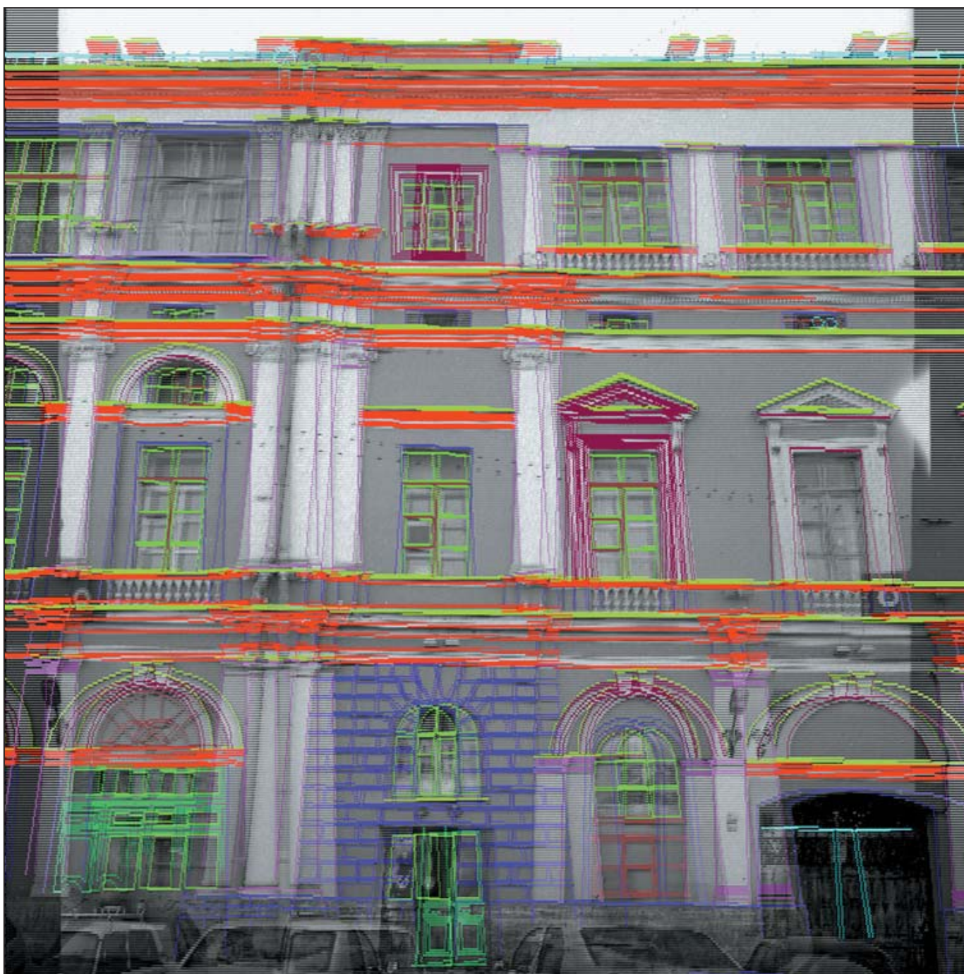
Рис.1. Стереоскопическая модель части Южного фасада здания Государственного Академического Мариинского театра.
