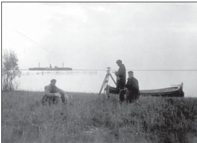
На нивелировании створных знаков. Побережье Финского залива, 1915 г.
