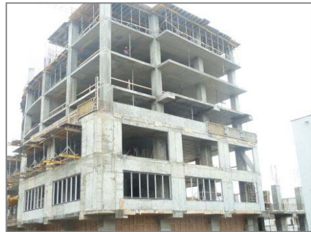
Рис. 1. Строящееся административное здание.
