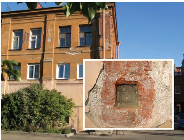
Рис. 8. Найденное закладное отверстие марки Шокальского-Витрама «№ 15» в кирпичной стене жилого дома на Обводном канале.
