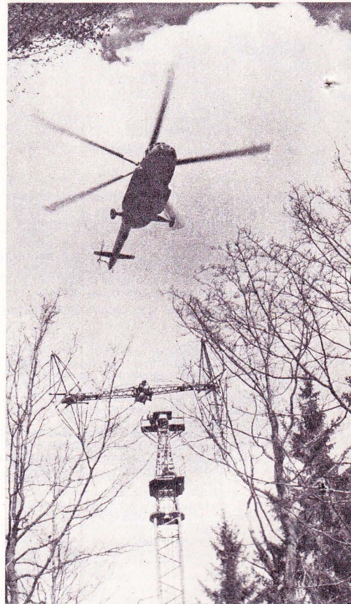
Вертолет Ми-8 эффективно используется в ГДР на монтажных работах.
