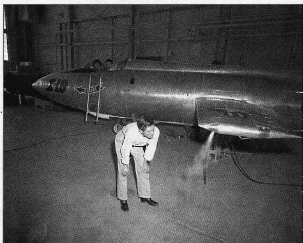
Проверка работы сопла газоструйной системы управления на X-1B
