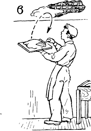
Рис. 14. Набрасывание раствора на сокол и на поверхность
