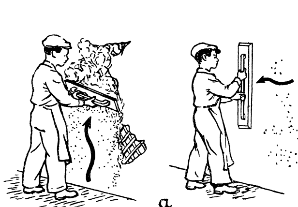
Рис. 15. Разравнивание раствора
