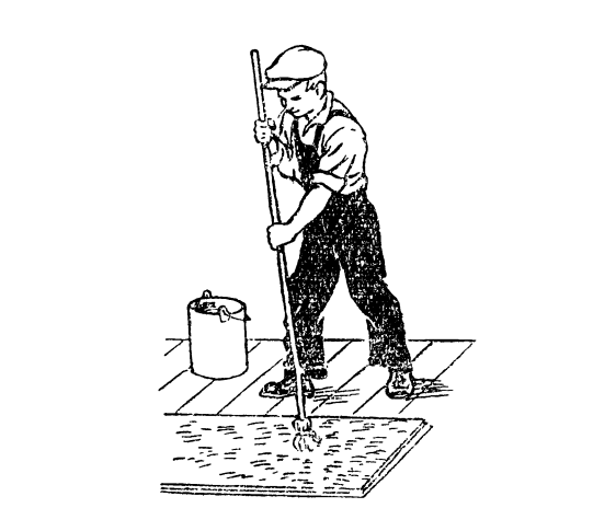
Рис. 9. Намазывание обоев клеем
