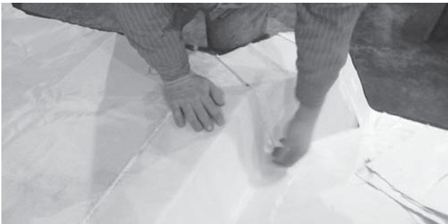
Рис. 11.8. Углы разглаживают для избежания образования складок и пустот
