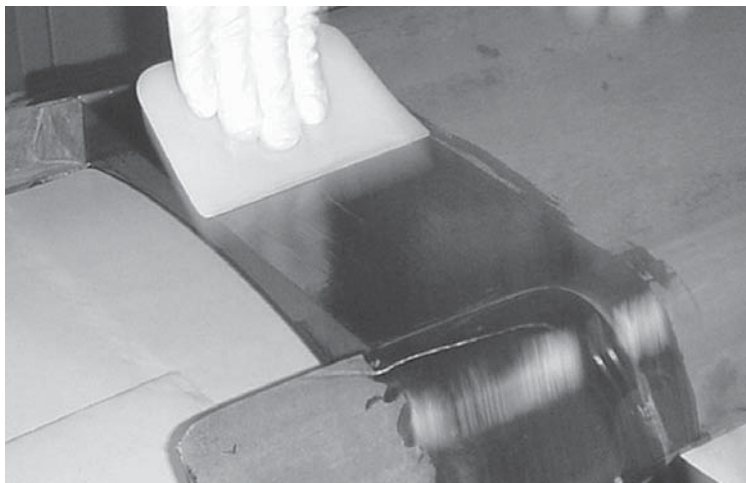
Рис. 11.11. Нанесение эпоксидной матрицы на углеродные волокна
