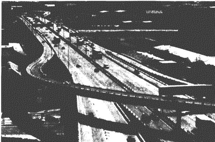
**Рис. 2.6.** Кингстонский мост в Глазго контролируется более чем в 1000 точках системой датчиков на длине более 4 км.
