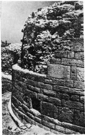
Рис 36 Внешний панцирь и забутовка башни Зенона в Херсонесе II в. до н. э.— IX в н. э. Строительным материалом служат квадры и глыбы местного известняка
