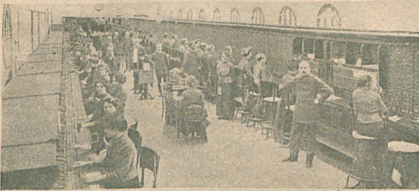
Телефонная станция в большом городе.
