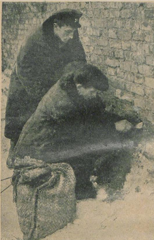
Зарядка скважины в стене патроном взрывчатого вещества.
