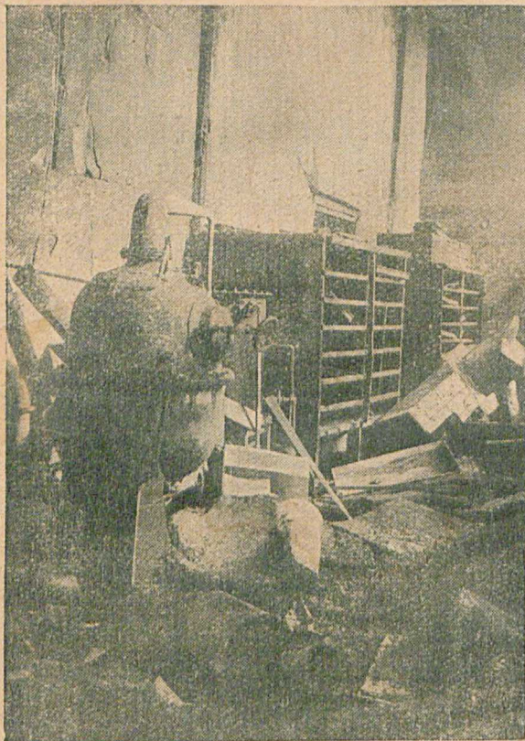
На снимках: слева аппарат для перегонки бензола, вывинтившаяся гайка которого вызвала взрыв; справа общий вид места взрыва.
