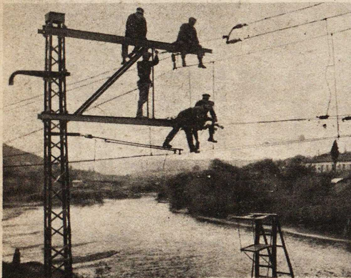
Монтаж высоковольтной линии у станции Зестафони
