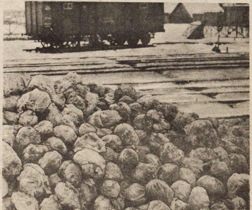
Станция Коломна. Капуста, погубившая вследствие неподачи вагонов в срок для ее перепковки
