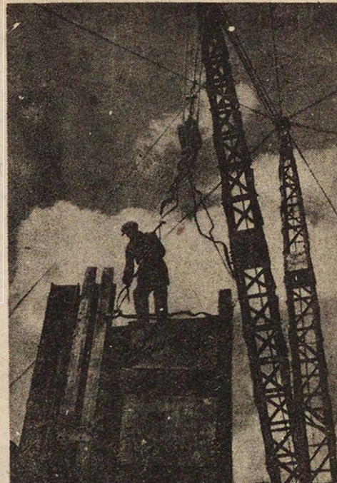
Растут мартены Магнитогорона. Установка железных конструкций маргеновского цеха Магнитогорского металлургического завода Фот. Д. Дебазова (Союзфото)
