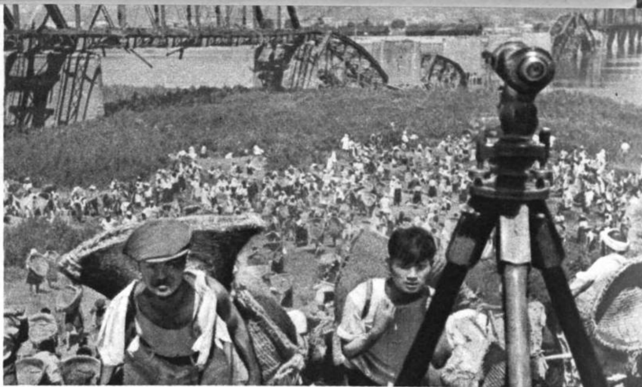
Жители восстанавливают разрушенный американскими воздушными гангстерами мост.
