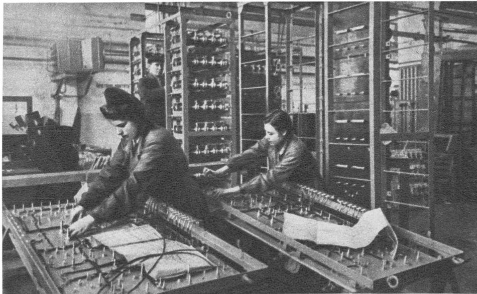
Москва. Завод «Динамо» имени С. М. Кирова. Монтаж контакторных панелей автоматического управления шлюзов.
