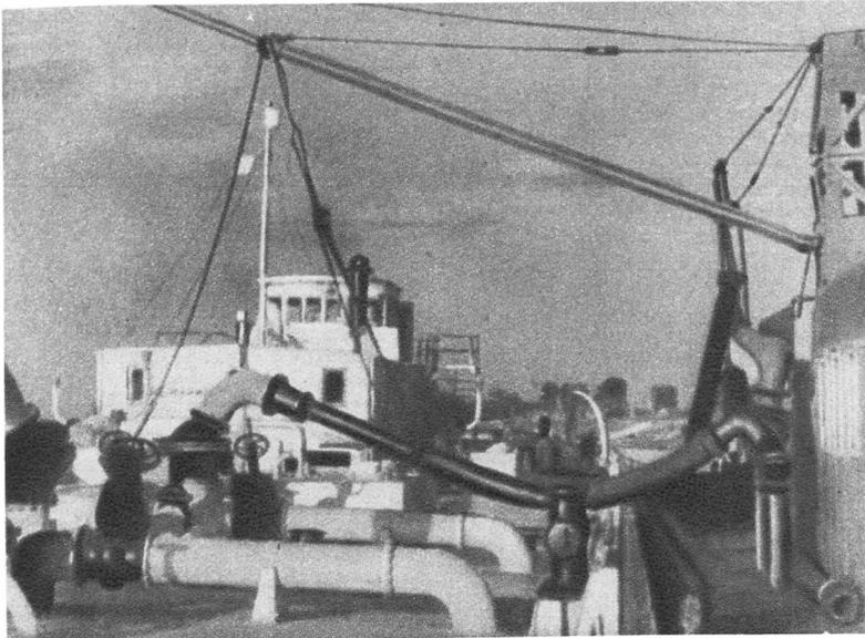
Шланг дымонагнетательной установки, оборудованной на баркасе, подключен к барже с бензином.
