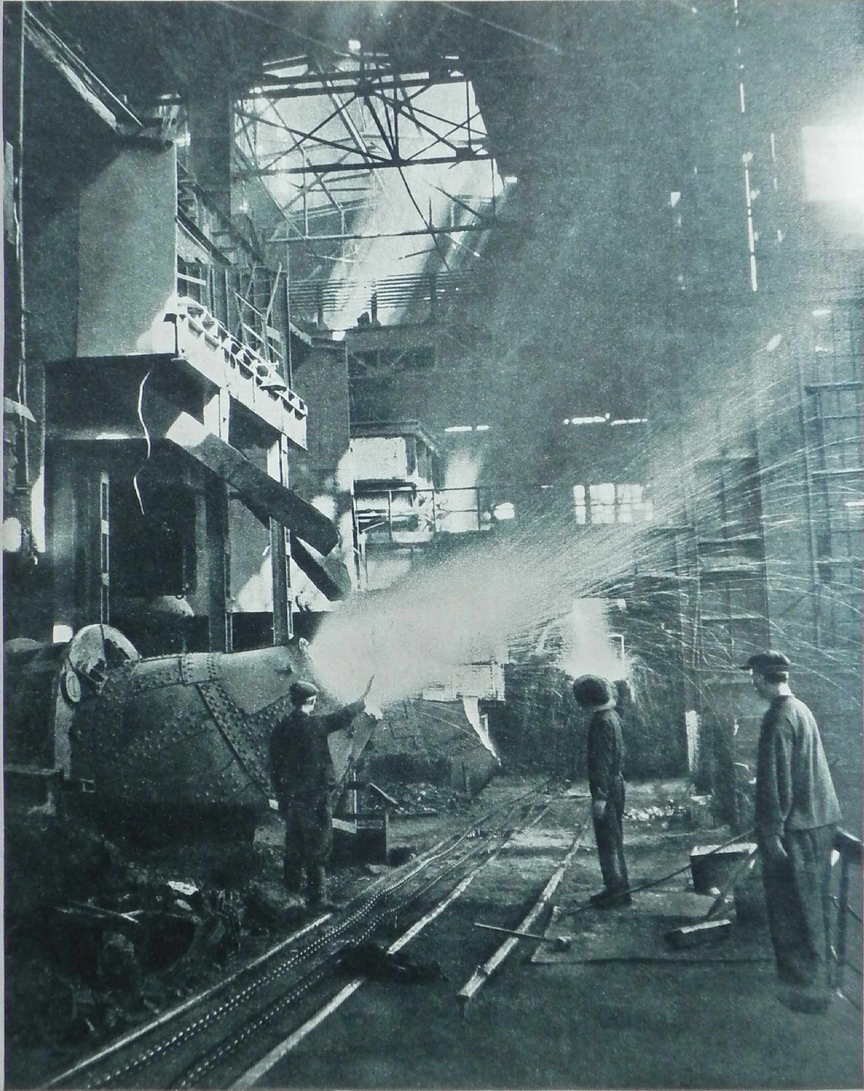
На Чусовском металлургическом заводе. Производство стали в бессемеровских конверторах.
