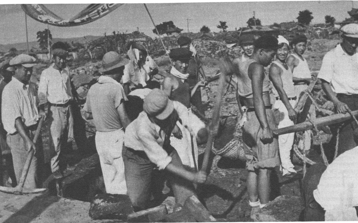
Бригады строителей расчищают улицы Пхеньяна от обломков.
