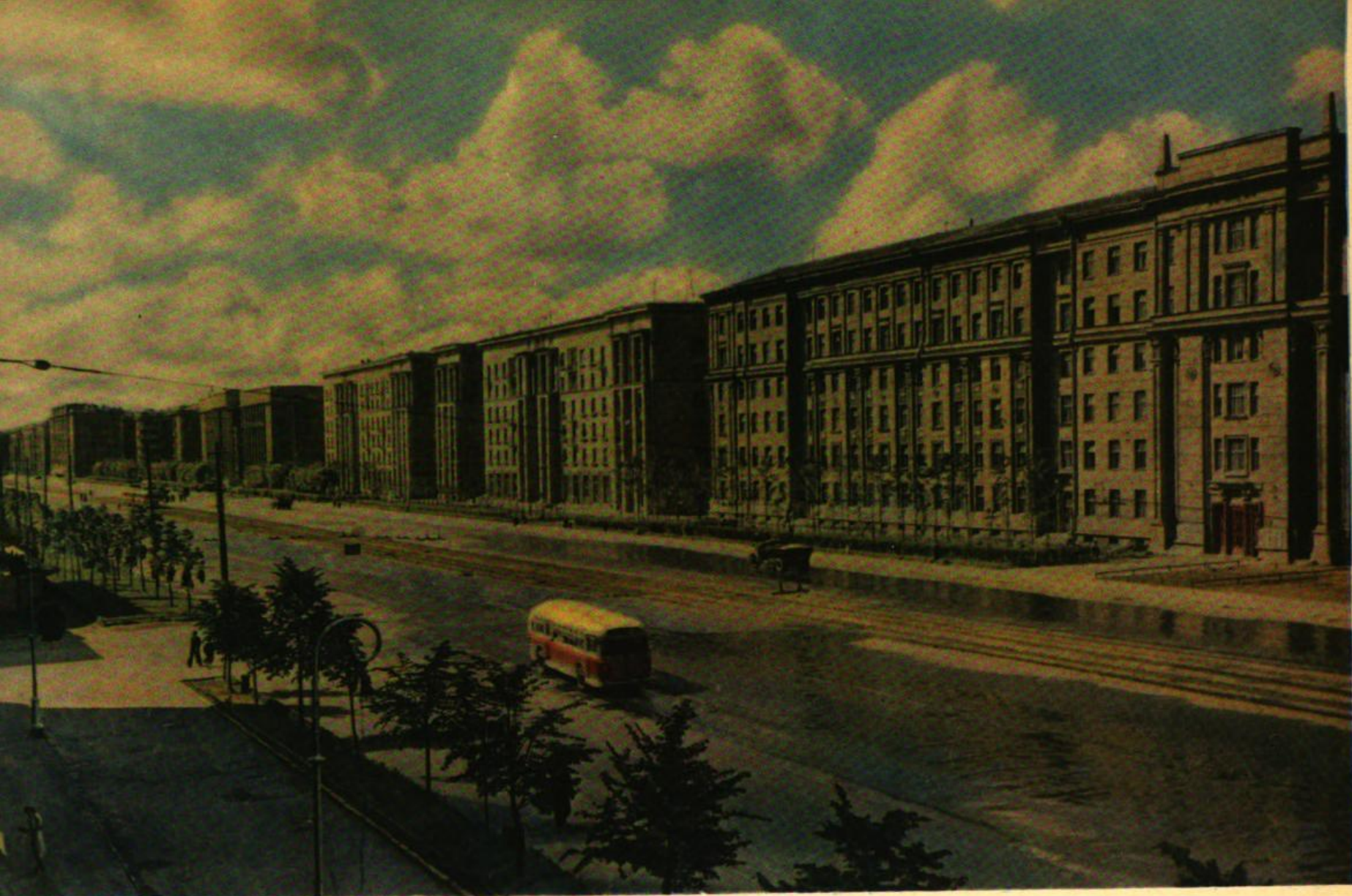
Проспект имени И. В. Сталина, район нового строительства.
