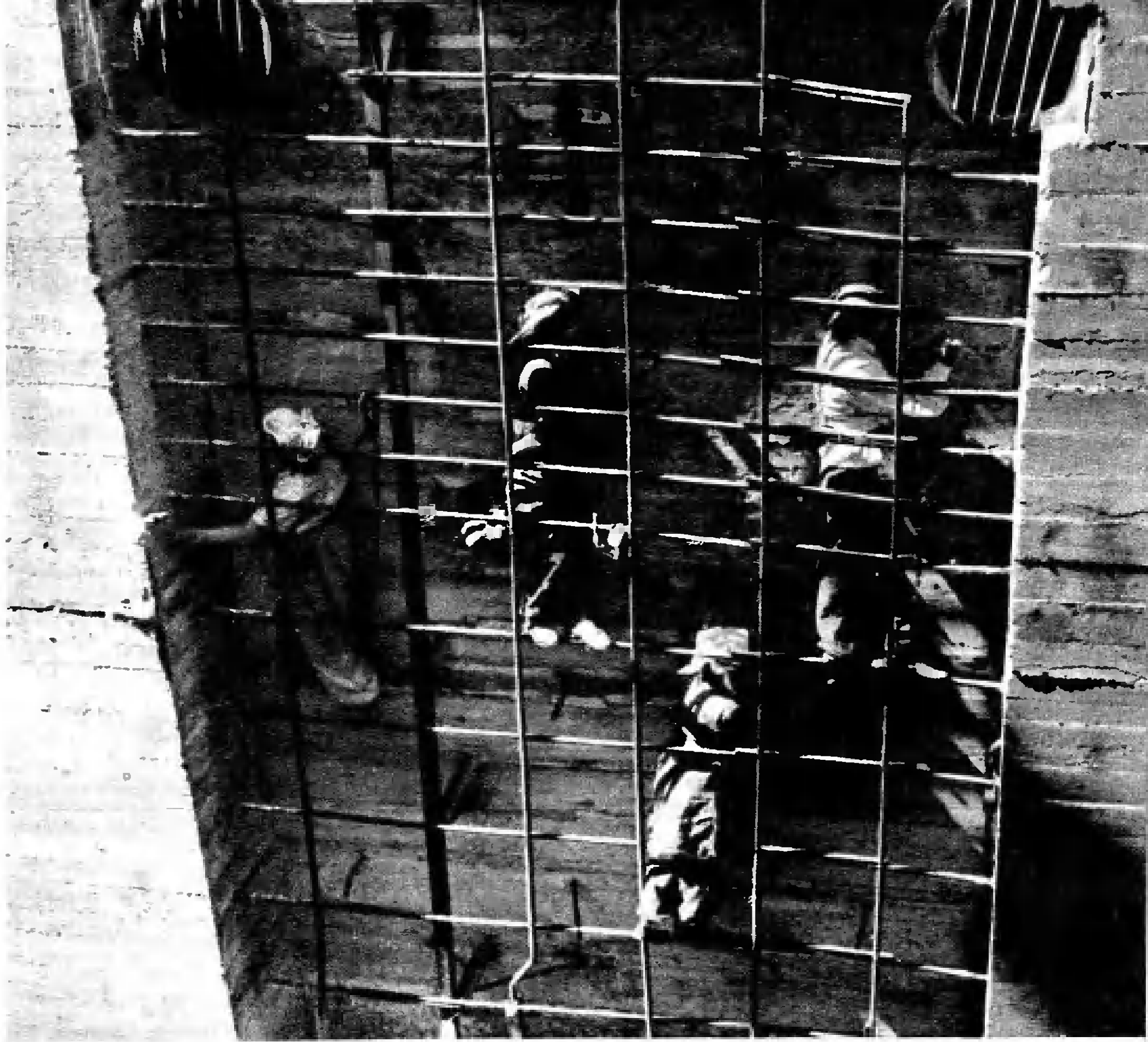
Насечка бетона.
