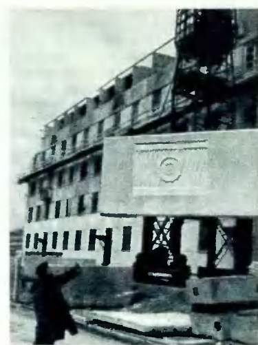
Строительство бескаркасного пятиэтажного жилого дома из армопенобетонных и бетонных плит в Березниках.
