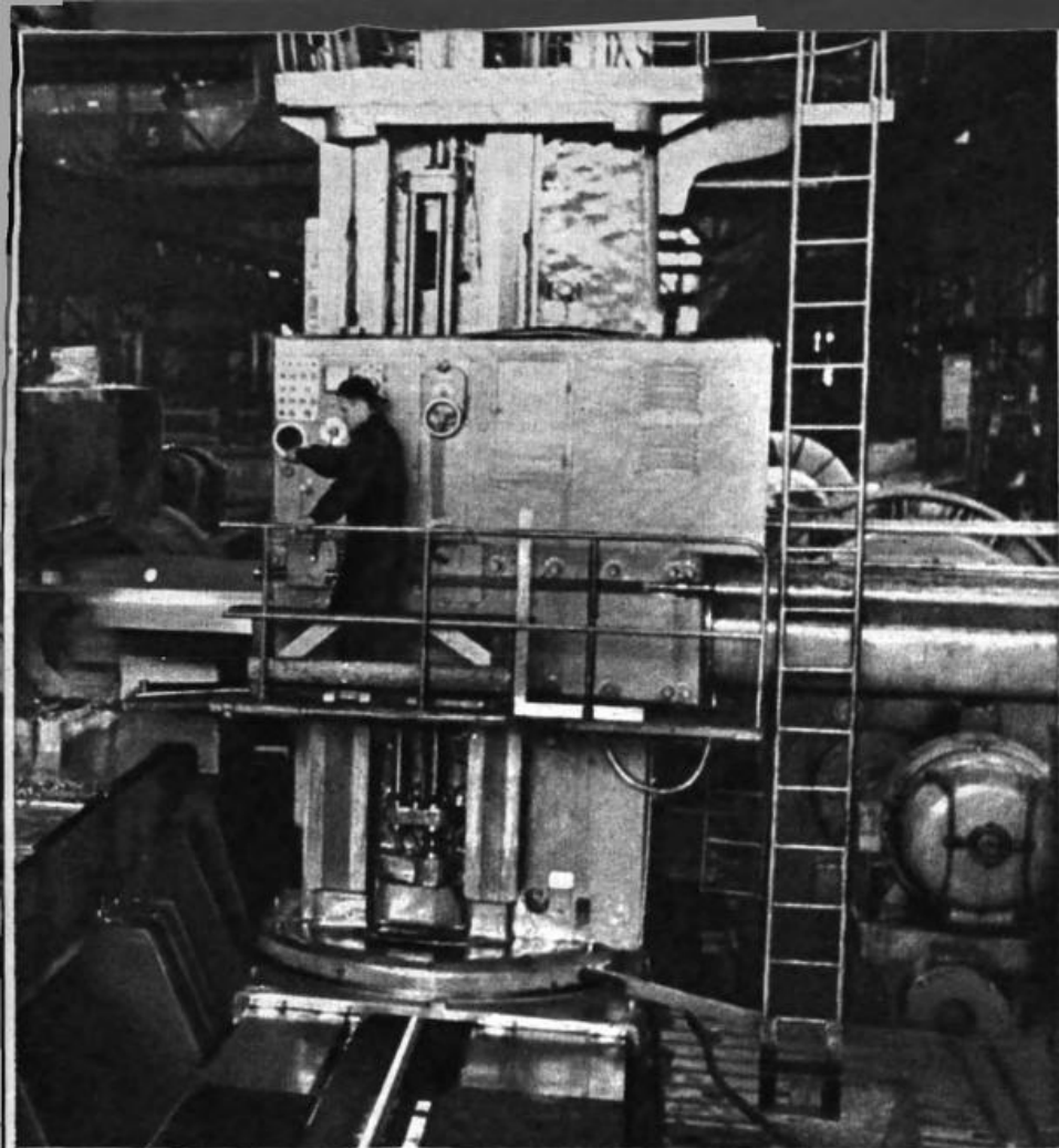
Обработка сложной детали в 120 тонн производится одновременно тремя станками.
