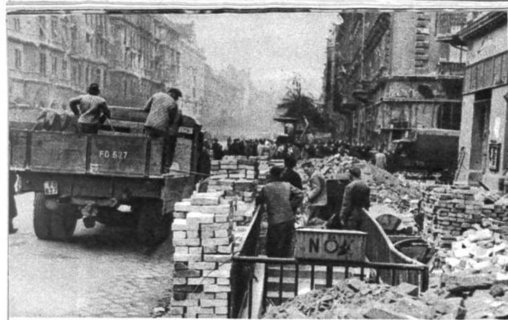
Улица Кёрут. Завозят кирпич и материалы для ремонта домов.
