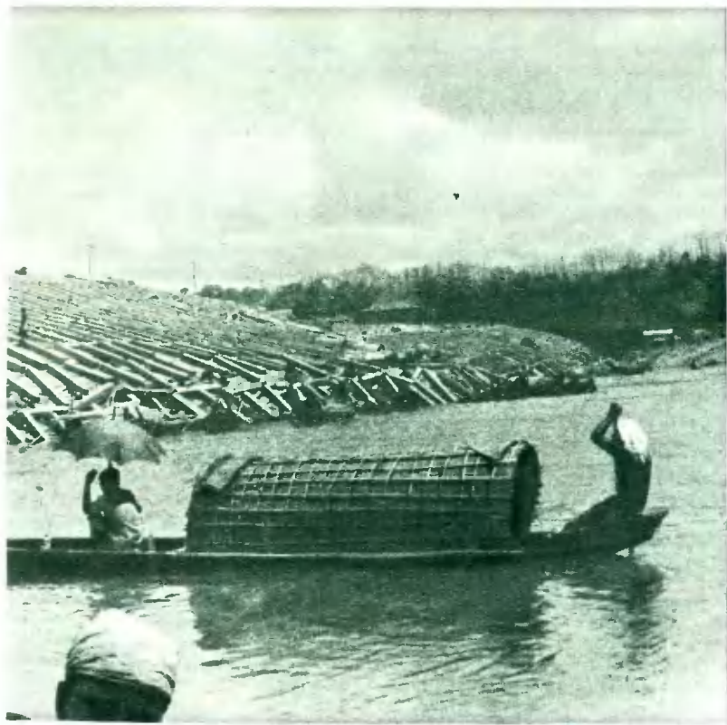
На строительстве Карнафульской ГЭС.
