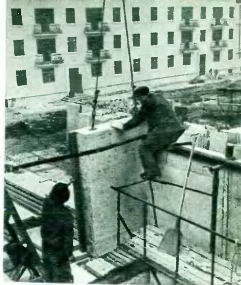
Строительство жилых домов из пенобетона в Березниках. Фото Ф. Короткевича.
