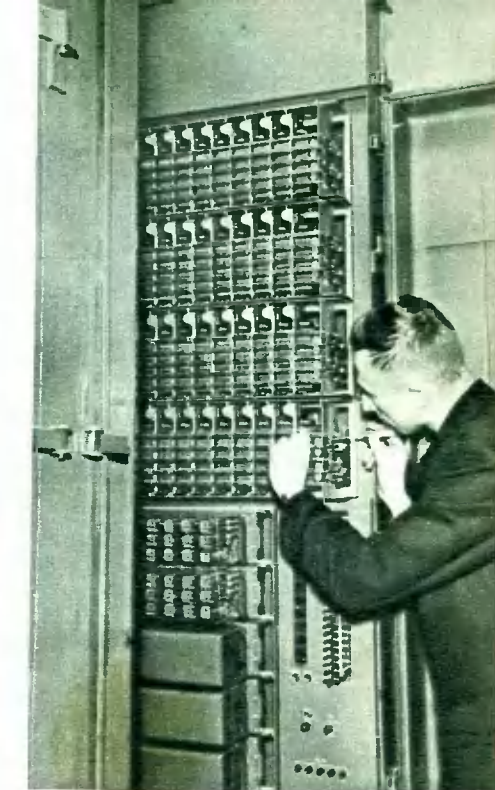
Новая автоматическая телефонная подстанция, установленная в доме на Московском проспекте в Ленинграде. Она обслуживает 100 квартир, хотя к зданию подведено всего 20 пар проводов.
