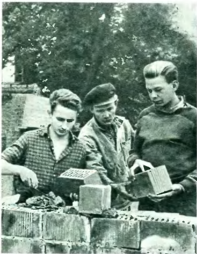
Лучшие каменщики стройки Хельдур Уньт и Мати Буна учатся у бригадира Адольфа Лийвера.
