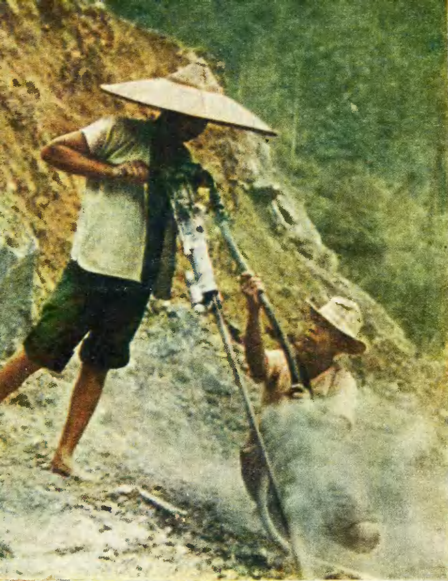
На строительстве гидроэлектростанции около Лойно.
