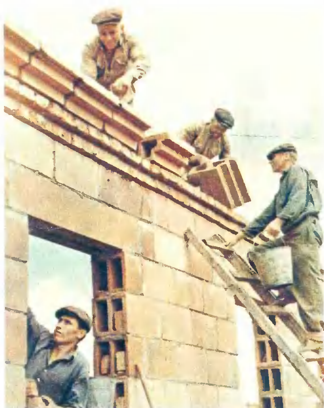
Новый свинарник в колхозе «40 лет Октября» строится из керамических блоков.
