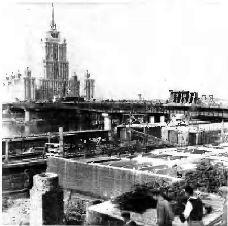
На строительстве Новоарбатского моста.
